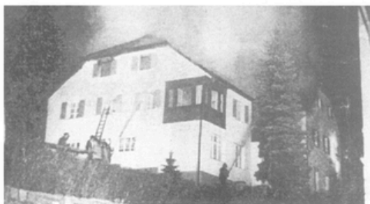
Brand bei Putz
