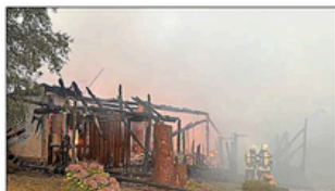
Die Rückseite des Gebäudes neben dem Parkplatz. Nur mehr verkohlte Balken blieben übrig.
