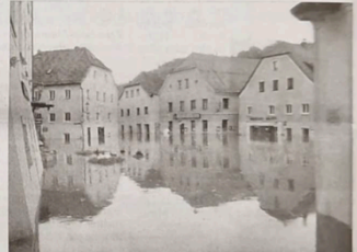
Über 1,50 Meter stand das Wasser der Ilz gestern Mittag am Halser Marktplatz. Viele Anwohner konnten ihre Häuser nicht mehr verlassen.
